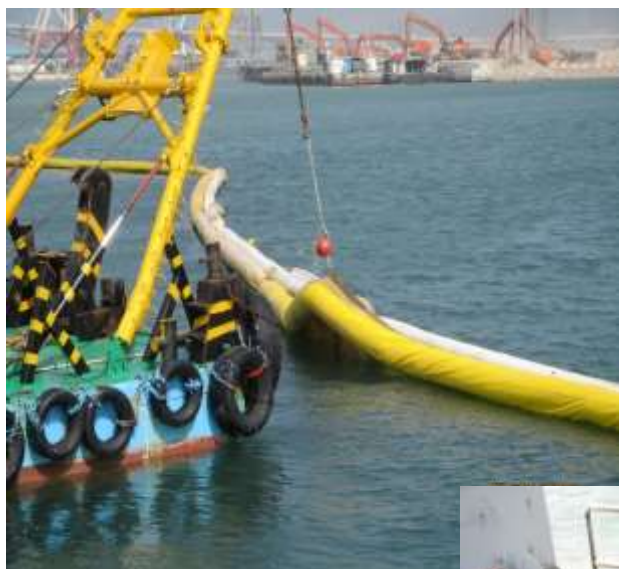
維修及保養淤泥屏障
